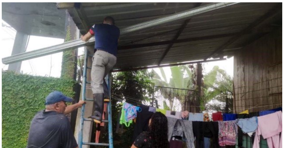
Neue Konstruktion von Regenrinnen zum Auffangen von Wasser, welches dann in der Gesundheitsstation und im Mehrzweckhaus verbraucht wird.
