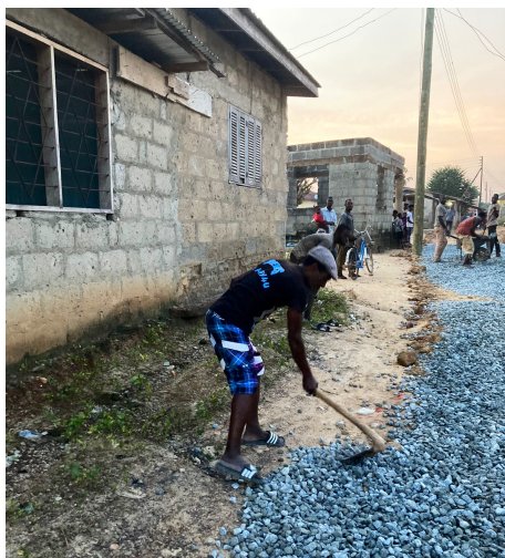
Eine neue Straße für den Weg von der Gesundheitsstation zum Dorf Boamadumasi
