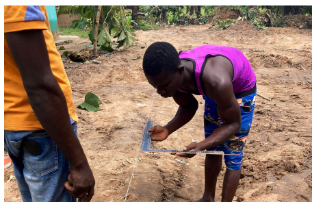
Vermessung für den Straßenbau
