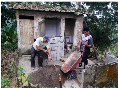
Ein neuer Vorratsraum für die Gesundheitsstation wird gebaut
