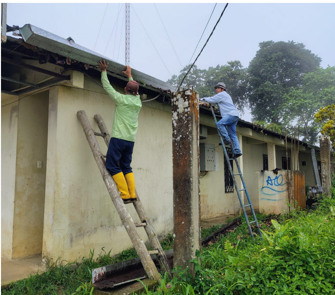
Instandhaltungsarbeiten an der Station
