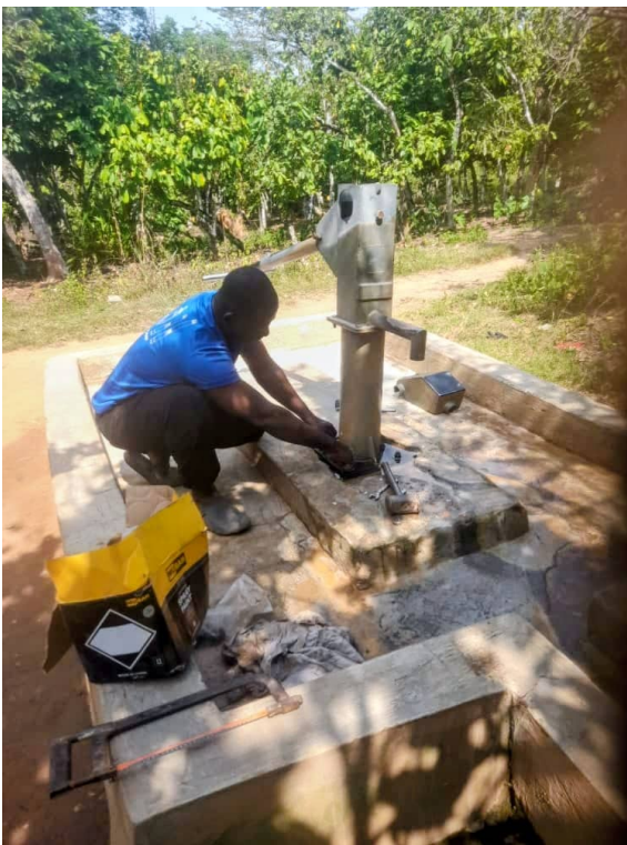
Reparatur eines Brunnens
