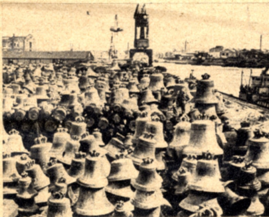
Πέντε χιλιάδες καμπάνες ἔχουν συγκεντρωθῆ ἀπὸ Γερμανοὺς, κλεμμένες ἀπὸ τὶς ἐκκλησίες.
