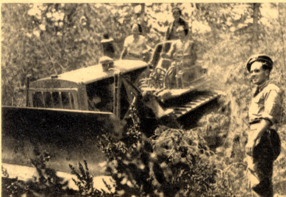
Ἡ ἀγρία φύσις τοῦ δάσους δαμάσθηκε ἀπὸ τὴ μηχανή. Ἐκεῖ ποὺ ποτὲ ἄλλοτε δὲν εἶχε περάσει ὁ κρότος μιᾶς μηχανῆς τώρα περνᾷ τὸ ἐκκαθαριστικὸ αὐτὸ μῆχανημα σαρώνοντας τὰ πάντα στὸ πέρασμά του γιὰ νὰ προλάβῃ τὴ διάδοσι τῆς φωτιᾶς. Μὲ τὸ σύστημα αὐτὸ δημιουργοῦνται κενά.
