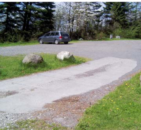
Näide hästi peidetud induktiivanduri kohta: on näha üksnes jooned, kus kaablid on paigaldatud maa sisse. Foto Store Durehavest, Taani, kus induktiivandurid on olnud pidevalt kasutusel alates 1977.a (FOTO: FRANK S. JENSEN)
