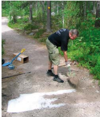
Sensormatt-loenduri paigaldamine Nuuksio Rahvusparki Soomes. (FOTO: TEEMU KIVIHARJU)
