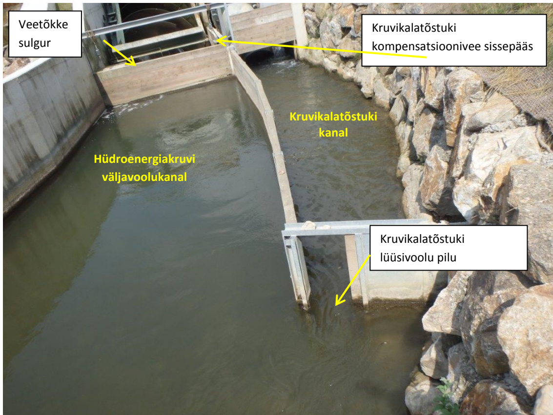
Joonis 4. Sisenemispilu kruvikalatõstuki kanalisse ja muud rajatised.
