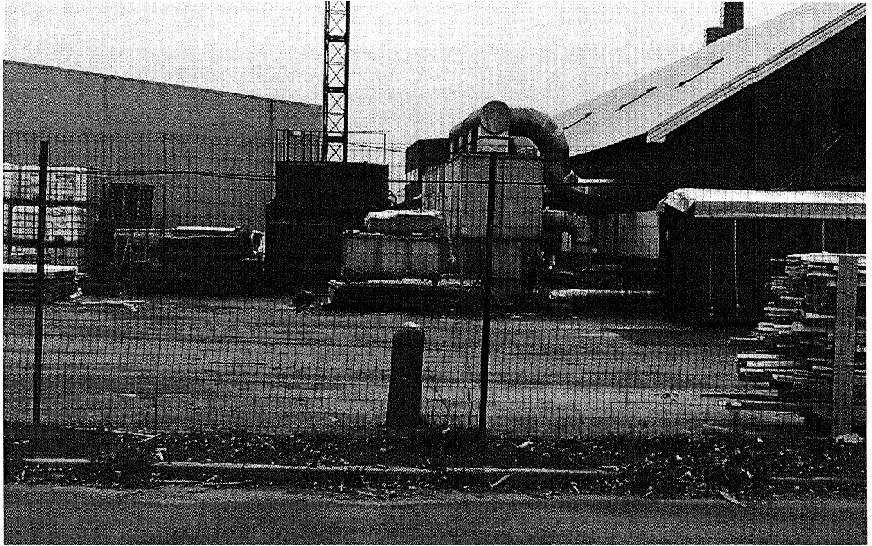
Mõõtepunkt MOD7. Väiksema tootmishalli ventilaator.
