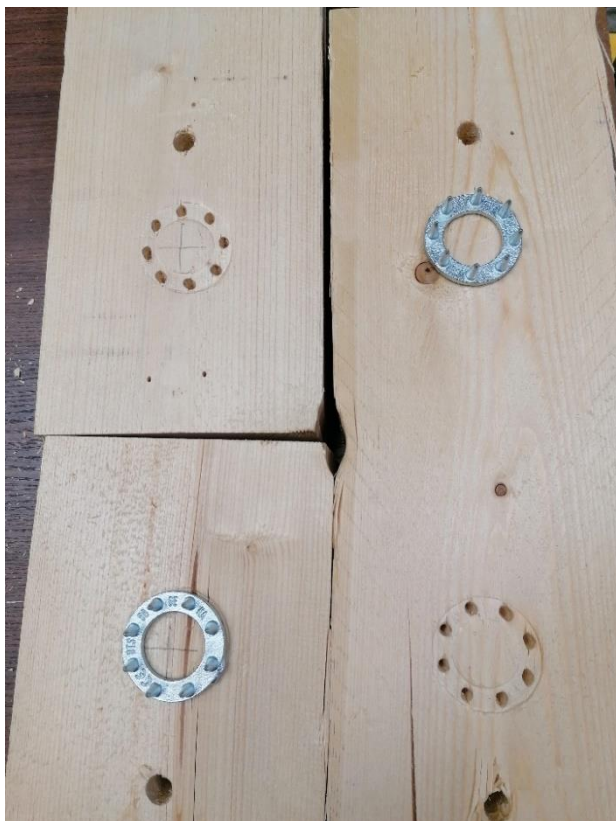
L5.1. Katsekeha JT1-C10 hammastüübli ja puidu muljumine.
