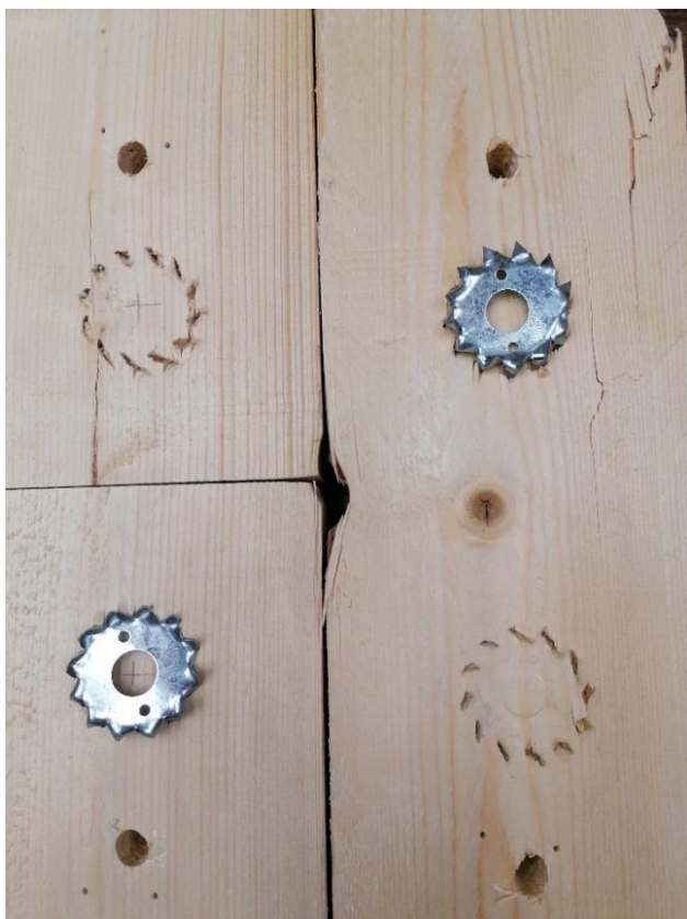
L4.8. Katsekeha JT8-C1 hammastüübli ja puidu muljumine.
