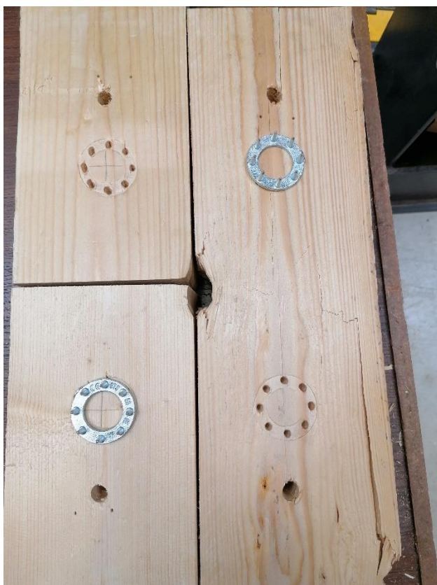
L5.3. Katsekeha JT3-C10 hammastüübli ja puidu muljumine.
