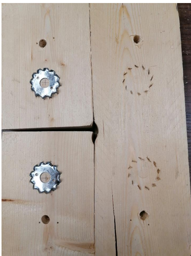
L4.10. Katsekeha JT10-C1 hammastüübli ja puidu muljumine.
