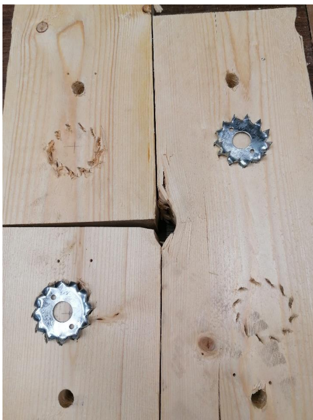
L4.6. Katsekeha JT6-C1 hammastüübli ja puidu muljumine.
