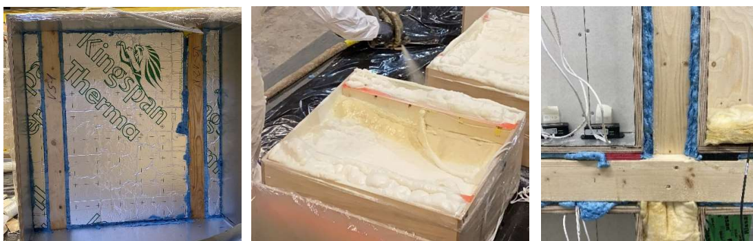
Joonis 2.22 Testseinte ehitus ja montaaž. Vasakult paremale: PIR soojustusplaadi paigaldus montaaživahuga, pritsitava plastvahu paigaldus, montaaživahuga tihendatud testelemendi ja puitsõrestiku vahe testhoones
