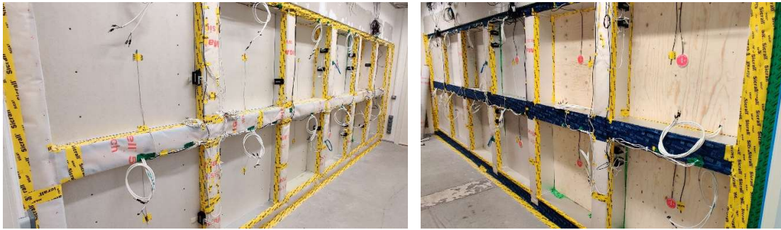
Joonis 2.23 Valmis testelemendid paigaldatud testhoonesse. Vasakul testruum niiskussisuga 2 g/m 3 ja paremal testruum niiskussisuga 6 g/m 3 . Mõlemas testruumis on ülemised testseinad kuiva karkassiga ning alumised testseinad märja karkassiga
