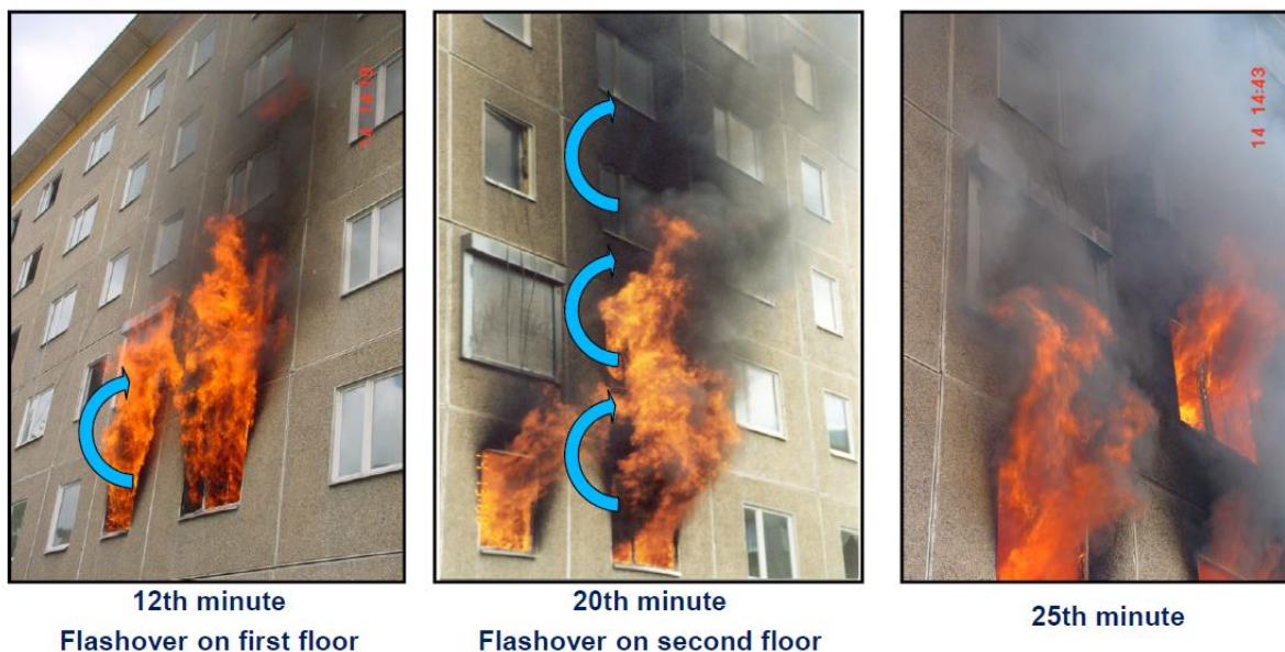
Joonis 7. Tule levik korruselt korrusele akende kaudu 10 .
