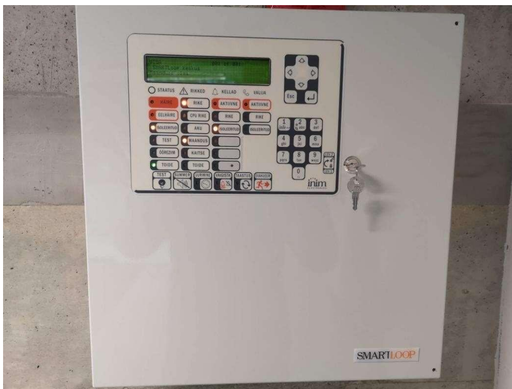
Foto. Kõrveküla Põhikooli ATS keskseade.
