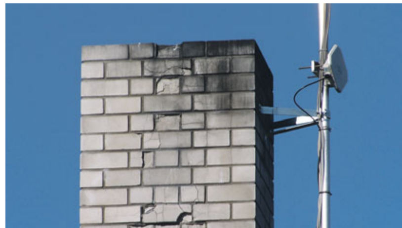
Telliskorstna seisukord pärast keskküttekatelet kasutuselevõttu.
