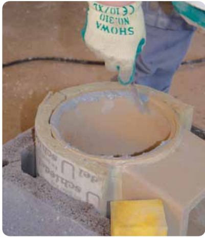
19. Nüüd kata liimiga kohe keraamilise toru ülemine ühendusserv. Nii on pärast lihtsam järgmist sisetoru paigaldada.
