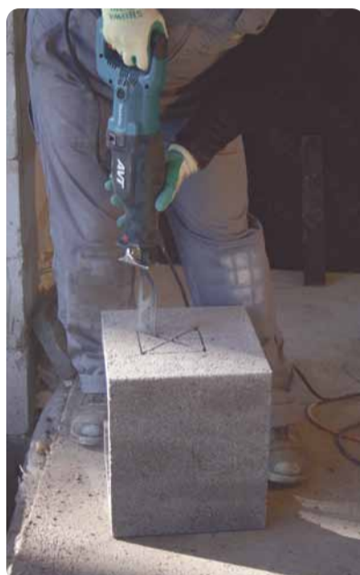
5. Ka puhastusluugi ava tuleb paika mõõda ning sisse lõigata. Lõikeavade servi on mugav siluda pendelsaega.
