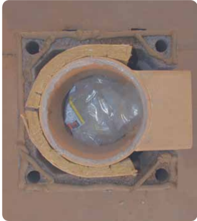
20. Korstna põhja aseta kiletükke vms, mis aitab hoida korstna põhja puhtana. Korstna püstitamise käigus kukub ikka korstnasse segutükke jms, mille saad hiljem koos kilega hõlpsalt eemaldada.
