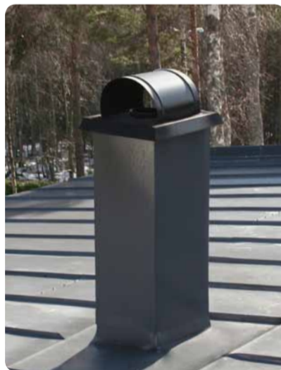
31. Katusest väljaulatava korstnaosa võib viimistleda kolmel eri moel: • krohvida korsten üle ilmastikukindla krohviga (ca 10 mm paksuselt); • katta korsten plekkümbrisega (pleki ja korstna vahele tuleks jätta ca 15 mm vertikaalne tuulutusvahe); • kasutada Final telliseimitatsiooniga viimistlusplokkide.
