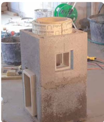
23. Paigalda puhastusluugi liitelement eelnevalt juba liimseguga kaetud sisetorule.
