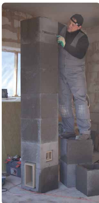
6. Pane korsten „kuivalt“ ehk ilma segu ja isolatsioonita kokku kuni siibri asukohani. See aitab paika saada lõigete ja avade kohad ning võimaldab vajadusel teha lihtsamini parandusi. Hiljem, seguga pannes, on keerulisem teha avades parandusi ning täiendusi.
