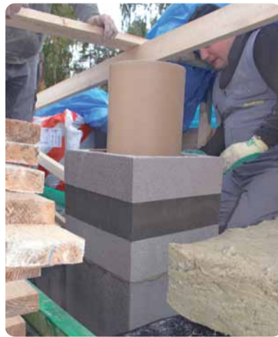
29. Thermosplit paigaldatakse nagu tavaline Rondo Plus moodulplokk, kasutades sama liimsegu.
