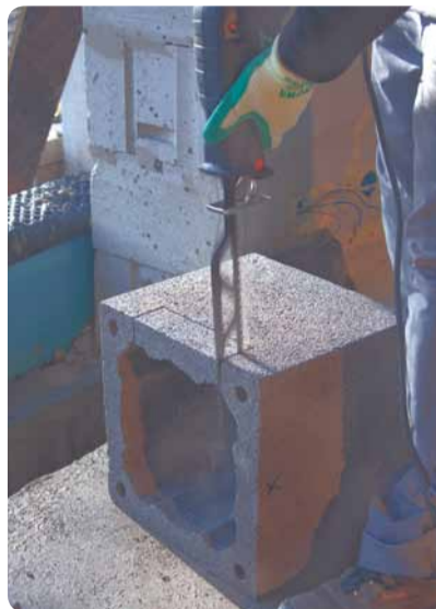
4. Ava lõikamine plokki liite/ühenduselementi sobitumiseks plokki sisse.
