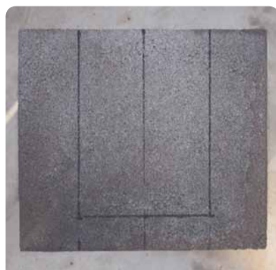
1. Esimesele plokile tasub ühenduselementi ava mõõdud täpselt peale joonistada.
