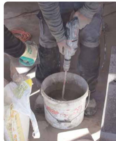
8. Valmista veest ja segupulbrist liimsegu. See peab olema parajalt paks, umbes nagu kohupiimapasta.
