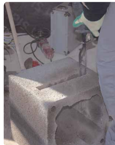
7. Siibri ava tegemine: mõõda, sae, toksi peitliga materjal välja, silu servad pendelsaega.
