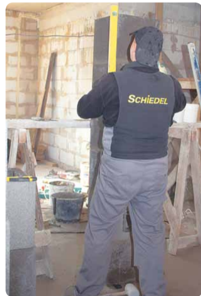
27. Alati loodi peale iga ploki paigaldamist korsten vähemalt kahest ristiasetsevast küljest. Korrigi kummihaamriga või kasuta vajadusel kiile.
