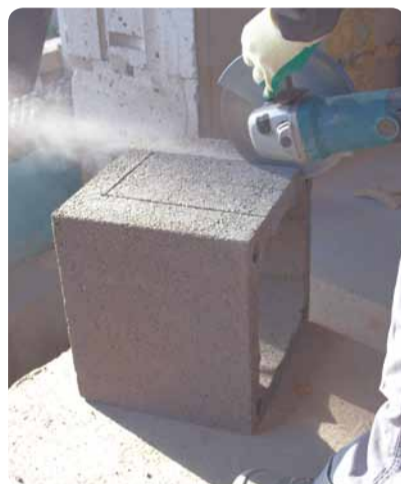
2. Ava lõikamine plokki ühenduselementi jaoks.
