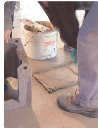
13. Märki plokki välisservi pliatsiga maha ning tõmba liim põrandale mõõda märgitud jooni.
