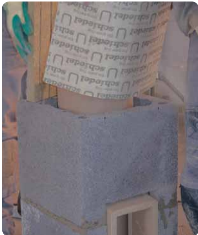
22. Aseta teine plokki paika ning eemalda üleliigne segu vuukide vahelt. Loodi vähemalt kahest ristiasetsevast küljest. Vajadusel korrigi kummihaamriga.
