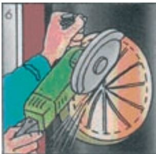
6. Lõigake ava šamott-torule ketaslõikuri või puuriga mööda kontuurjoont. ÄRGE KASUTAJE LÖÖKMEHCHANISME!
