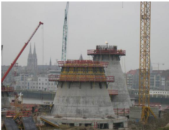
Joonis 9. Gravitatsioonvundamendi ehitus kaldal (325 MW avamere tuulepark Belgias)
