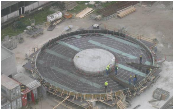
Joonis 8. Paigaldatud gravitatsioonvundament (325 MW avamere tuulepark Belgias)
