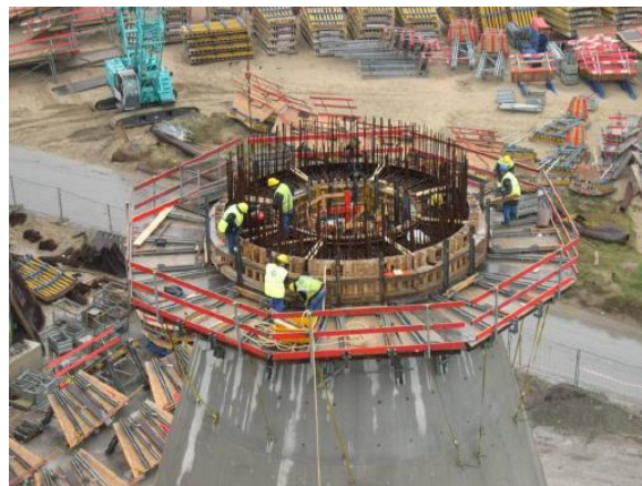
Joonis 9. Gravitatsioonvundamendi ehitus kaldal (325 MW avamere tuulepark Belgias)
