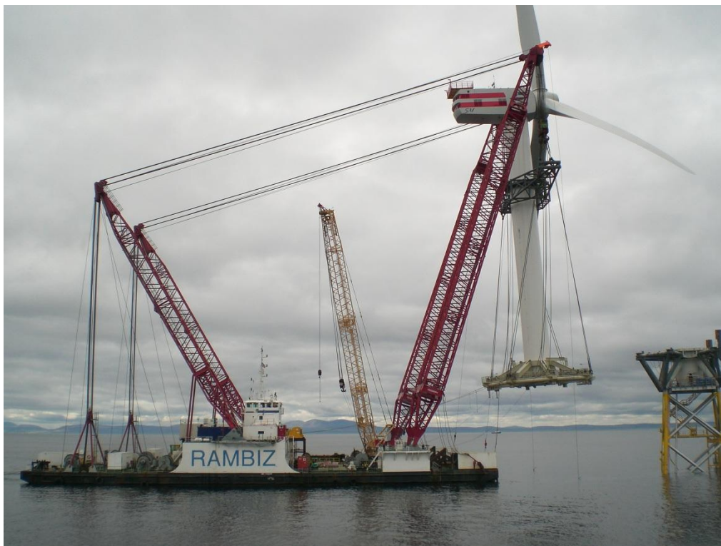
Joonis 3.7. Repower 5MW tuuliku paigaldus. http://www.repower.de/
