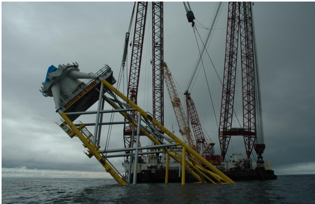
Joonis 3.6. Repower 5M sõrestikvundamendi paigaldamine. http://www.repower.de/index.php?id=237&L=1
