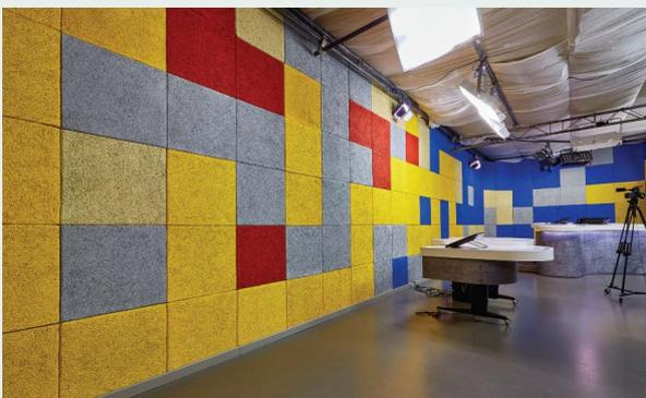
Akustikplatten sorgen für professionelle Schalldämmung mit maximaler Geräuschdämmung und reduzieren die Schallreflexion.
