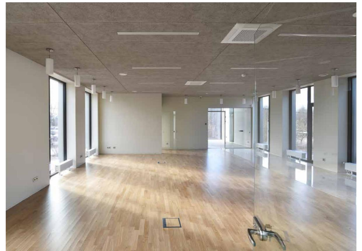
Abgehängt mit Nonius-Hänger 0,40 kN
