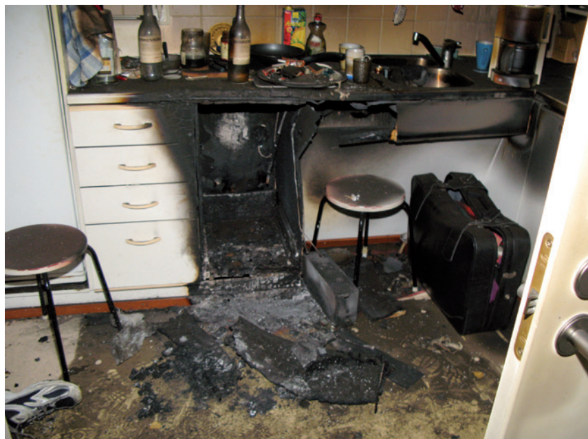
Kuva 3: Kytenyt, itsestään sammutunut ja palavan materiaalin määräältä vähäinen tulipalo johti kahden henkilön kuolemaan.
