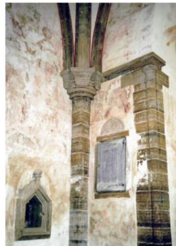
Kohalikust põlemisjälgedega onkoliit-dolomiidist raidtööd Muhu kirikus, 13. s
