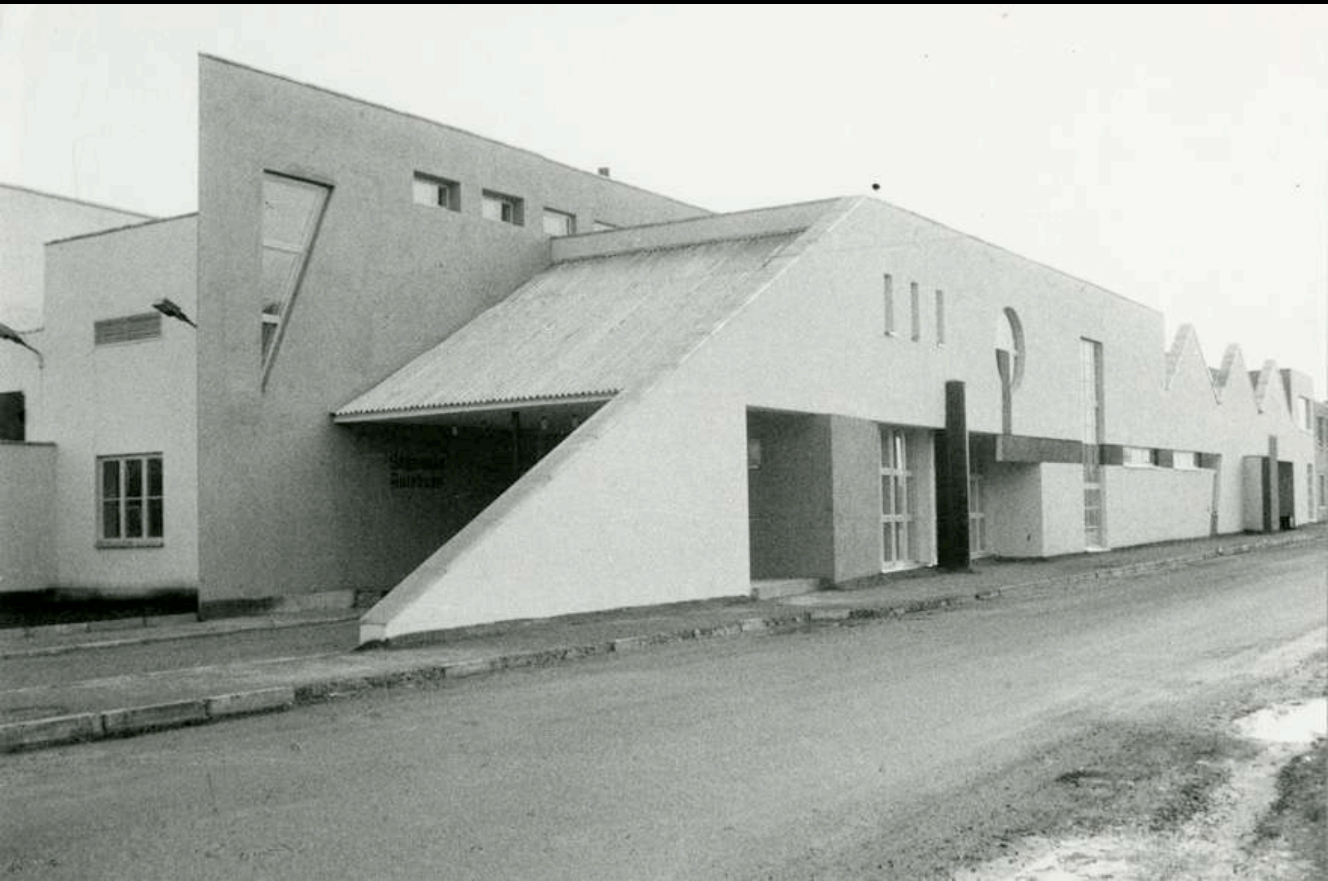
Arh Raivo Puusepp. Autobaasi hoonekeompleks Pihla tee 20, 1989-93
