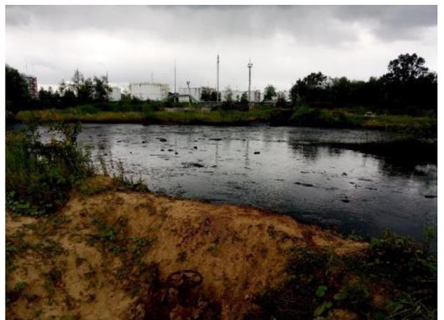
Рисунок 37. Шламовий амбар № 4 ЦППН, ознаки переливу відходів через край обвалування, липень 2019
