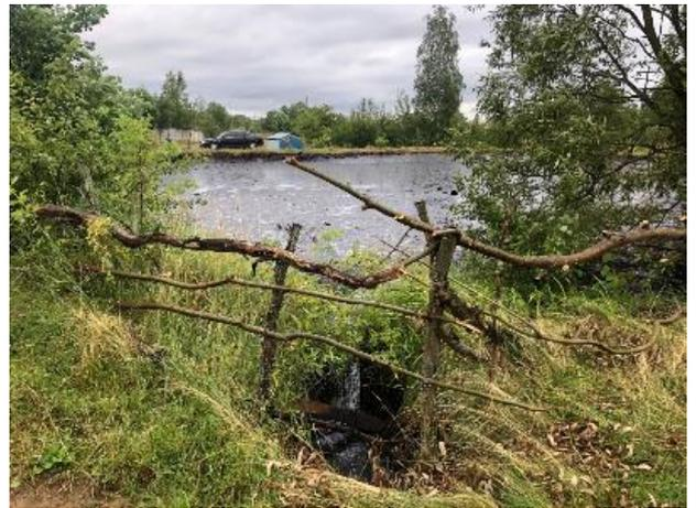
Рисунок 42. Порушення огороження та обвалування амбару № 2 ГТУ-3
