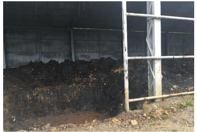
Рисунок 75. Перелив та розповсюдження нафтошламів за межами шламонакопичувача
