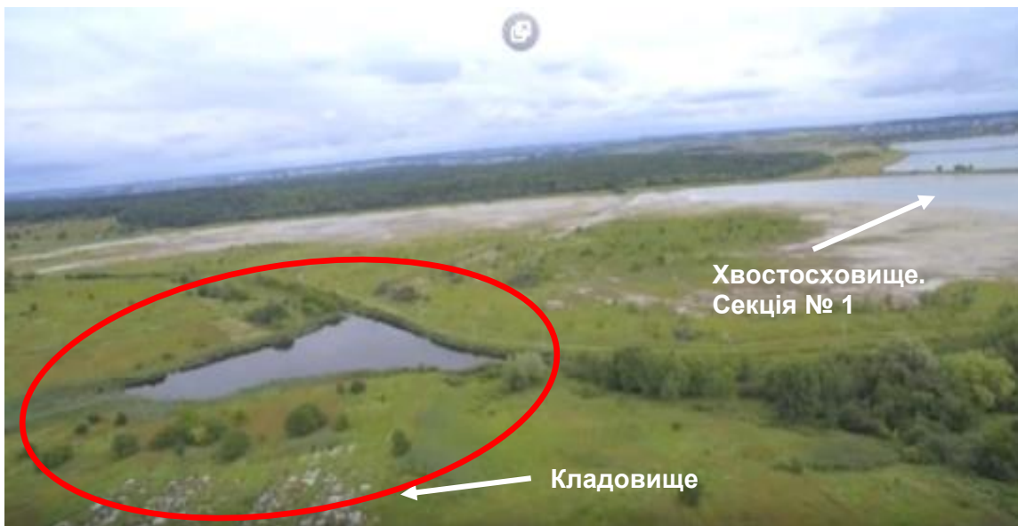
Рисунок 67. Аерофотозйомка. Ознаки підтоплення поряд з секцією № 1 хвостосховища
