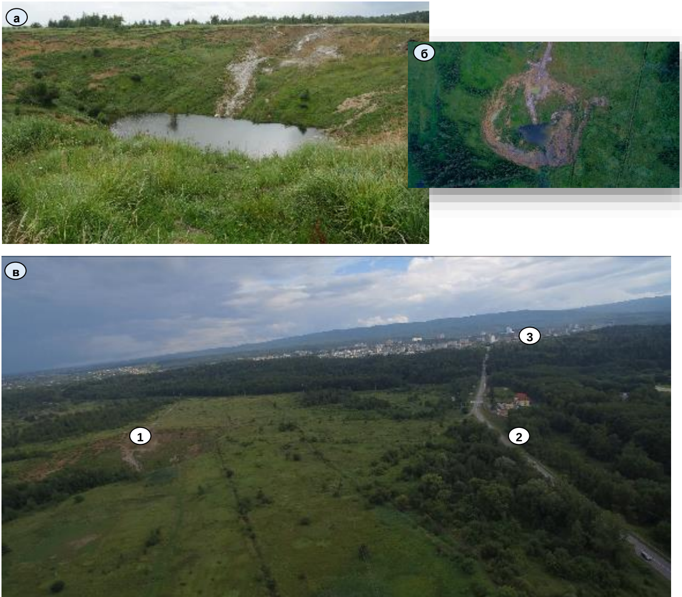
Рисунок 64. Карстовий провал на території гірничого відводу рудника № 2, дата зйомки – липень 2018 року. Рис. а – загальний вид, рис. б - вигляд зверху, аерофотознімок, рис. в - місцевість біля карстового провалу (1): автодорога (2), м. Трускавець (3)
