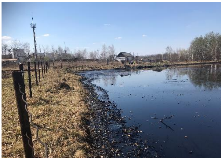
Рисунок 33. Рівень заповнення амбару № 1 ЦППН доходить до краю обвалування, квітень 2019
