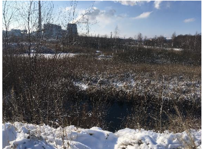
Рисунок 22. Підтоплення на ділянці аварійної секції золошлаковідвалу
