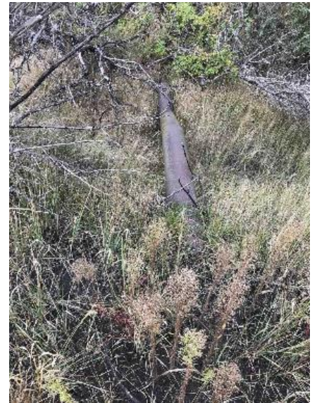
Рисунок 83. Трубопровід за дамбою золошлаковідвалу
