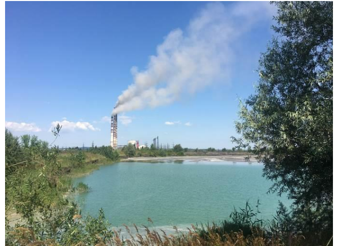
Рисунок 45. Вид на споруди ТЕС з території золовідвалу № 1, 2
