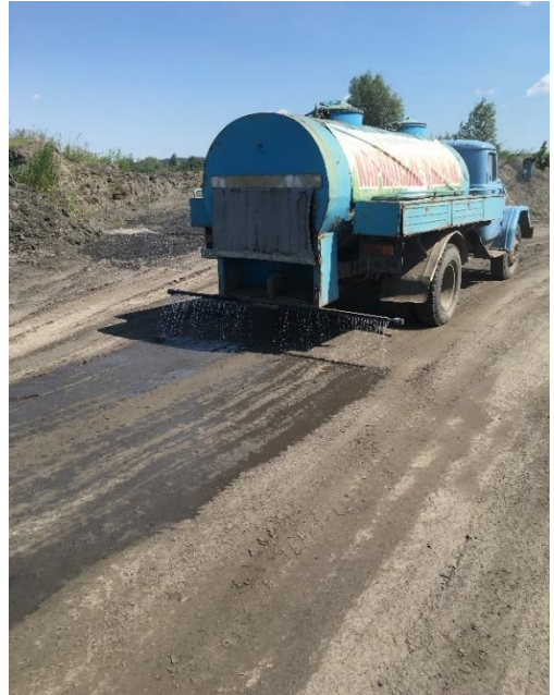
Рисунок 51. Золівідвал № 1,2. Інтенсивне пиління та захід з пилоподавлення
