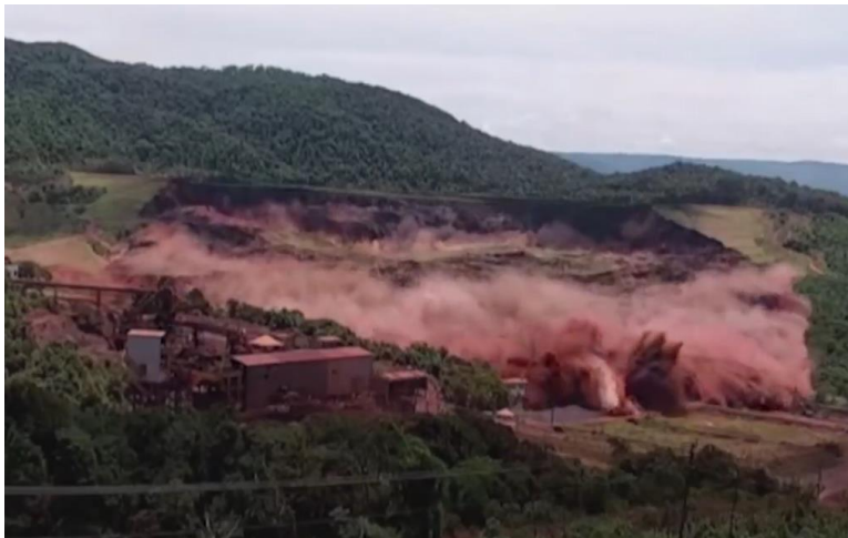
Рисунок 1. Момент руйнування дамби хвостосховища, Бразилія, 2019. Фото: The Guardian News, відеокадр
