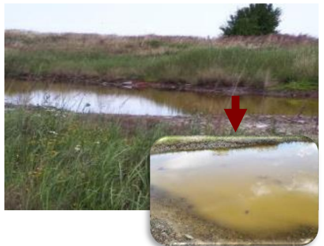
Рисунок 9. Накопичення атмосферних опадів на поверхні хвостосховища № 1, липень 2018
