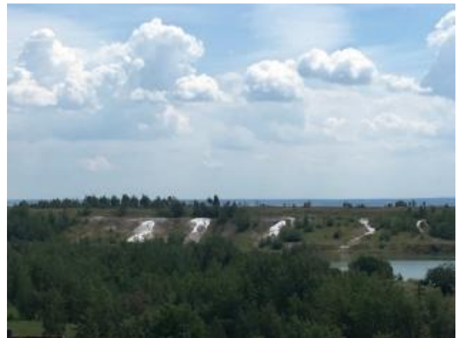
Рисунок 12. Просочування солей через дамбу хвостосховища № 1, липень 2018
