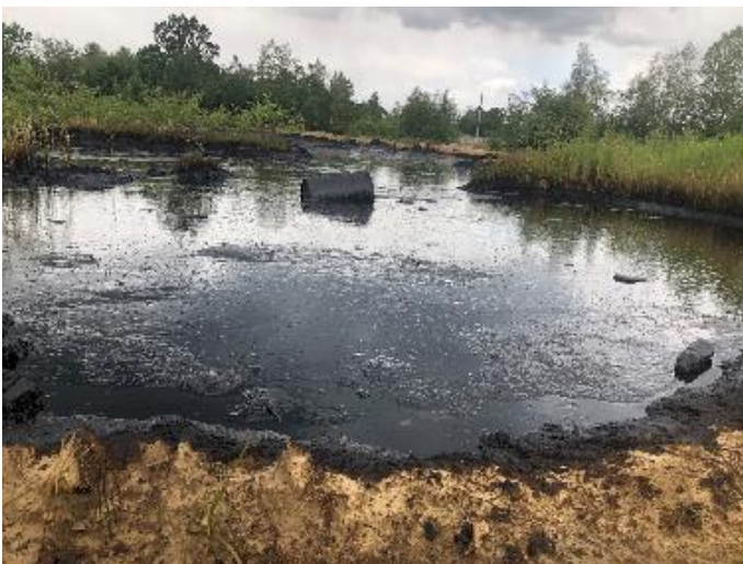
Рисунок 37. Шламовий амбар № 4 ЦППН, ознаки переливу відходів через край обвалування, липень 2019
