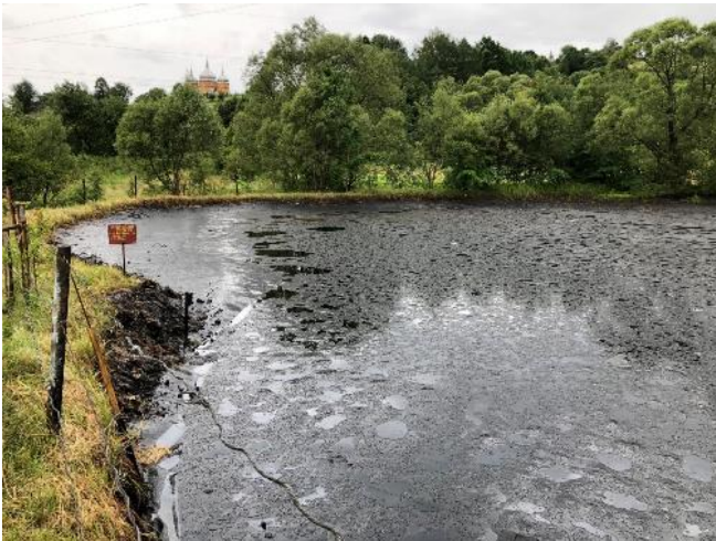
Рисунок 41. Амбар № 2 ГТУ-3, критичний рівень заповнення, липень 2019
