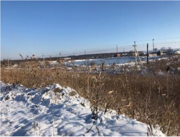
Рисунок 17. Шламонакопичувач цеху НіОПСВ. Вид з золошлаковідвалу ДП «Калуська ТЕЦ-НОВА»
