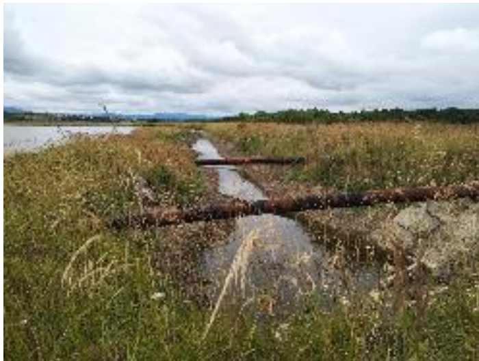
Рисунок 65. Хвостосховище, нагірний канал
