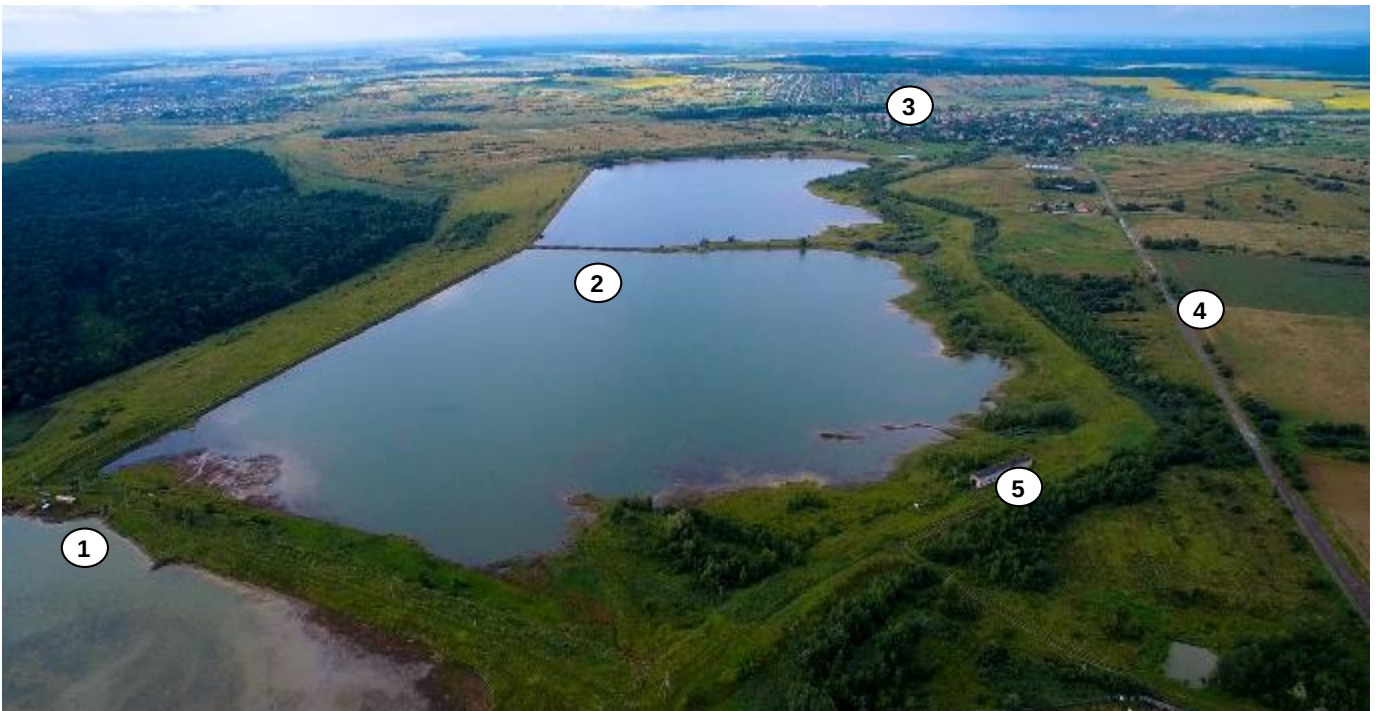
Рисунок 62. Аерофотознімок. Хвостосховище та прилегла територія. Позначення: 1- секція № 1, 2 - секція № 2, 3 – населений пункт с. Болехівці, 4 – автомобільна дорога, 5 – насосна станція
