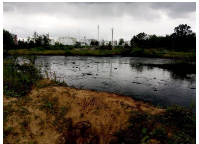
Рисунок 37. Шламовий амбар № 4 ЦППН, ознаки переливу відходів через край обвалування, липень 2019
