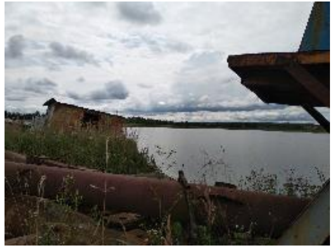
Рисунок 66. Прилегла територія та споруда берегової насосної станції
