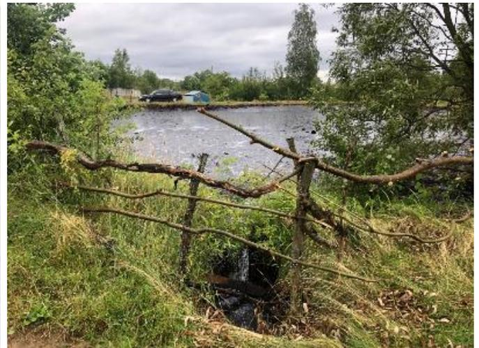
*Рисунок 42. Нарушение ограждения и обвалования амбара № 2 ГТУ-3*
