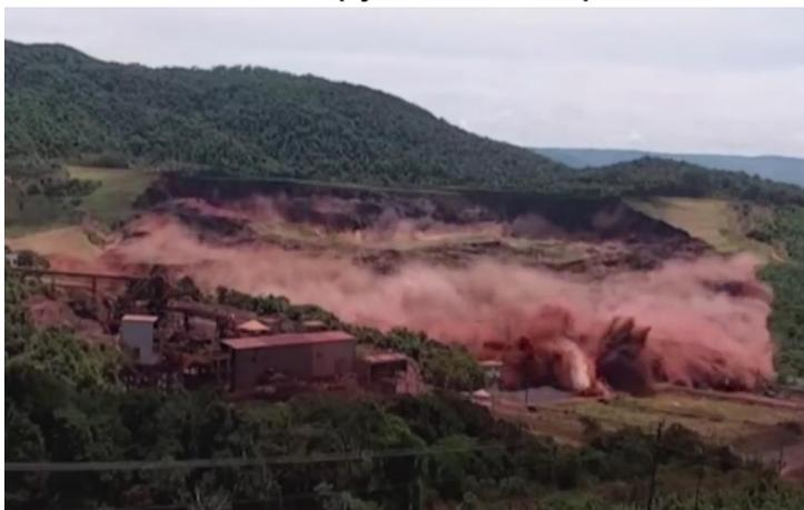
Рисунок 1. Момент разрушения дамбы хвостохранилища, Бразилия, 2019.
