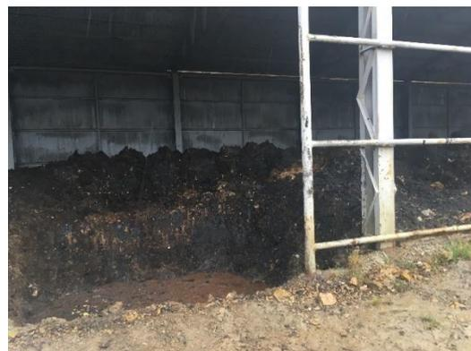
*Рисунок 75. Перелив и распространения нефтешламов за пределами шламонакопителя*
