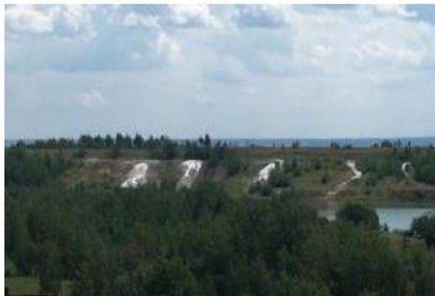
Рисунок 12. Просачивания солей через дамбу хвостохранилища № 1, июль 2018
