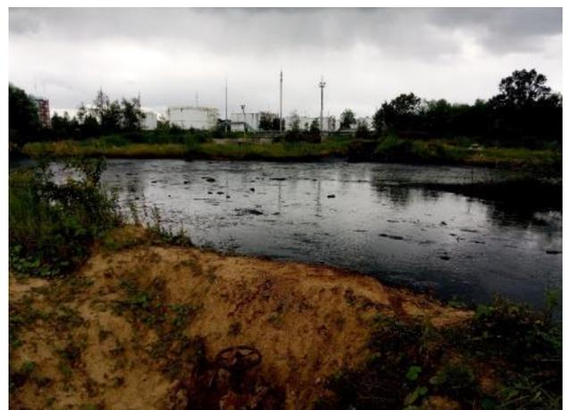
Рисунок 37. Амбар № 4 ЦППН, признаки перелива отходов через край обвалования, июль 2019
