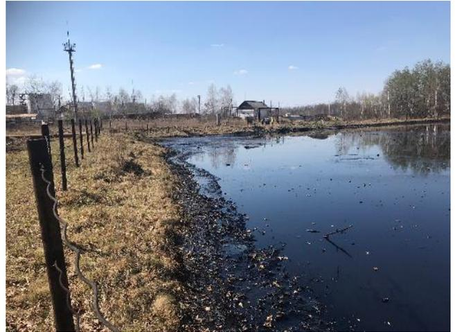
Рисунок 33. Уровень заполнения амбара № 1 ЦППН доходит до края обвалования, апрель 2019
