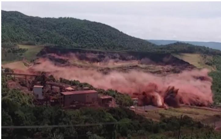
Рисунок 1. Момент разрушения дамбы хвостохранилища, Бразилия, 2019. Фото: The Guardian News, видеокادر
