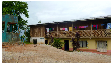
Gefahr gebannt: Hier hat der Wasserturm gestanden
