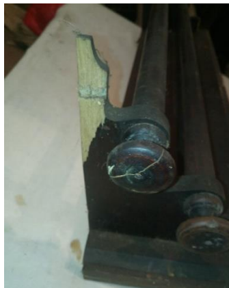
Puidu kahjustused siini otstes ja siine toetaval seinal
