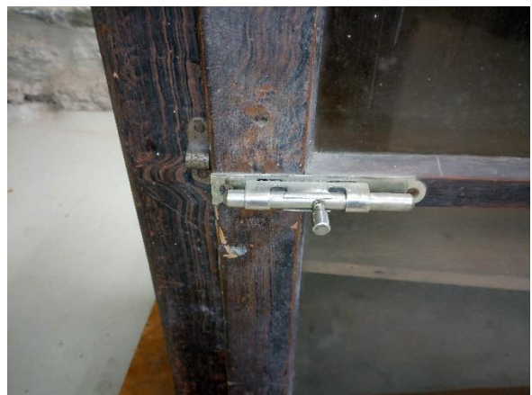
Uksele paigaldatud lukandriiv
