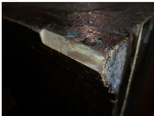
Rihvaserva pind on tasandatud ja valmis liimimiseks.
