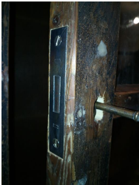
Lukk on paigutatud lukupesasse ja kinnitatud kruvidega
