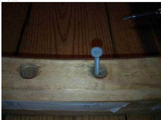
Naagli eemaldamiseks keerati kruvi naagli jalamis oleva kiilu sisse.
