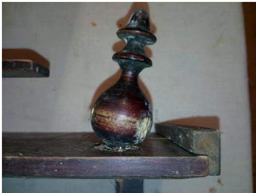
Parempoolne baluster - detailil puudub jalg.
