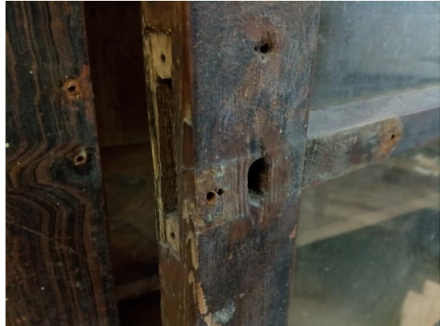
Lükandriiv ja riivi vasturaud on eemaldatud.
