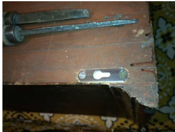
Riputusaas on kinnitatud kruvidega oma pesasse
