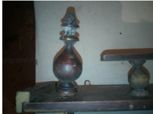
Vasakpoolne baluster. Detail on terviklik kuid kinnitusest lahti ja viimistlus kahjustunud.
