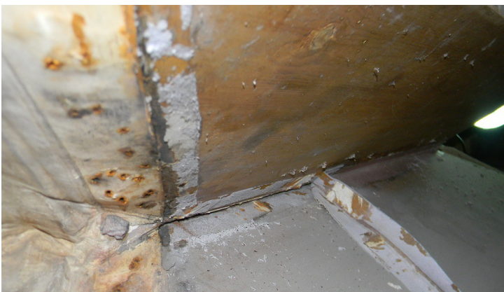
Lõõtsa puhastamine vanast nahast.
