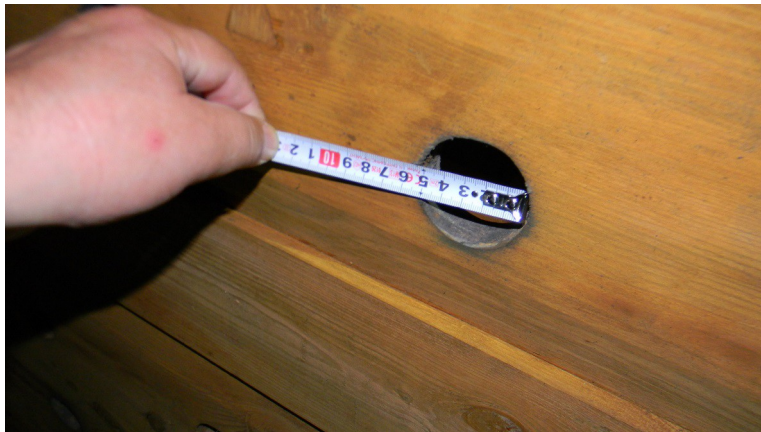
Üks lõõtsa sissevõtuklapi avadest.
