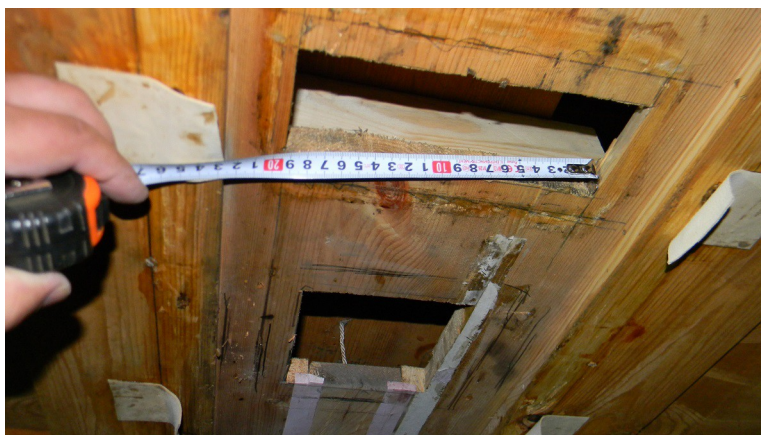
Toitelõõtsa paigaldamine.
