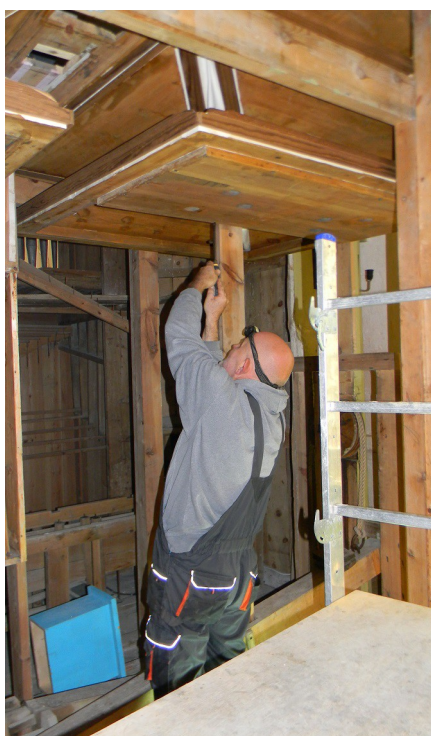
Toitelõõtsa paigaldamine.
