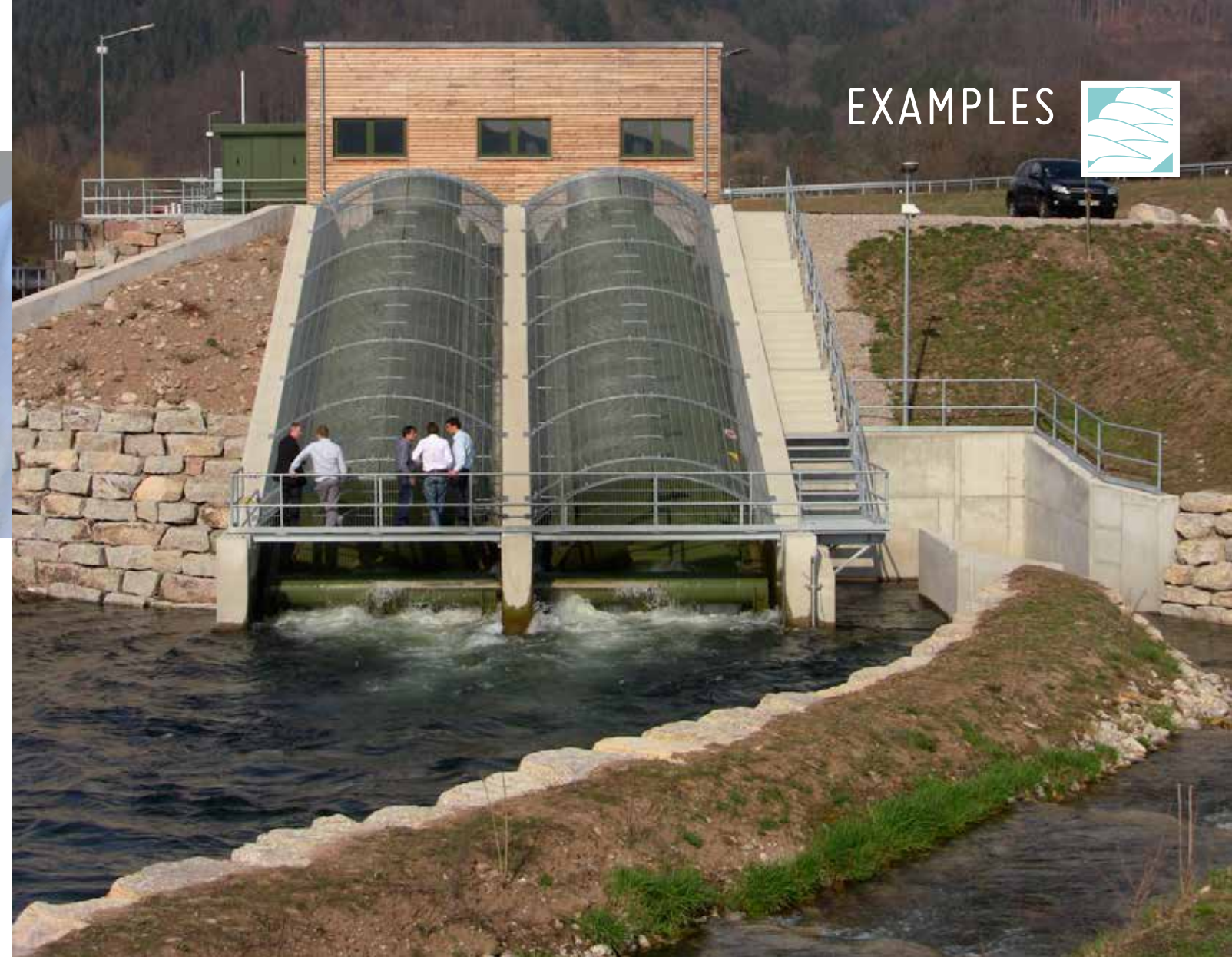
500 kW system, steel trough for casting (type SH), Hausen im Wiesental
