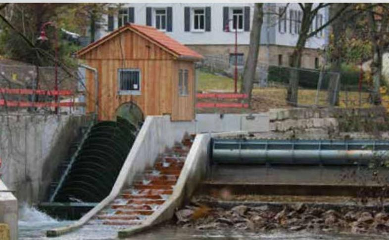
HYDROPOWER SCREW AND WEIR GATES
