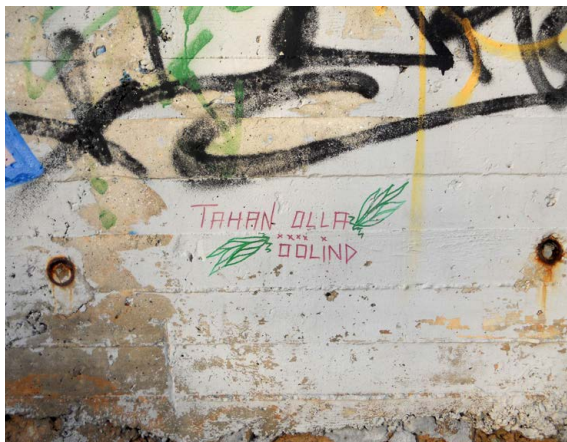
Foto 25. Tartu, Sõpruse sild. Foto: Piret Voolaid, dets 2013.
