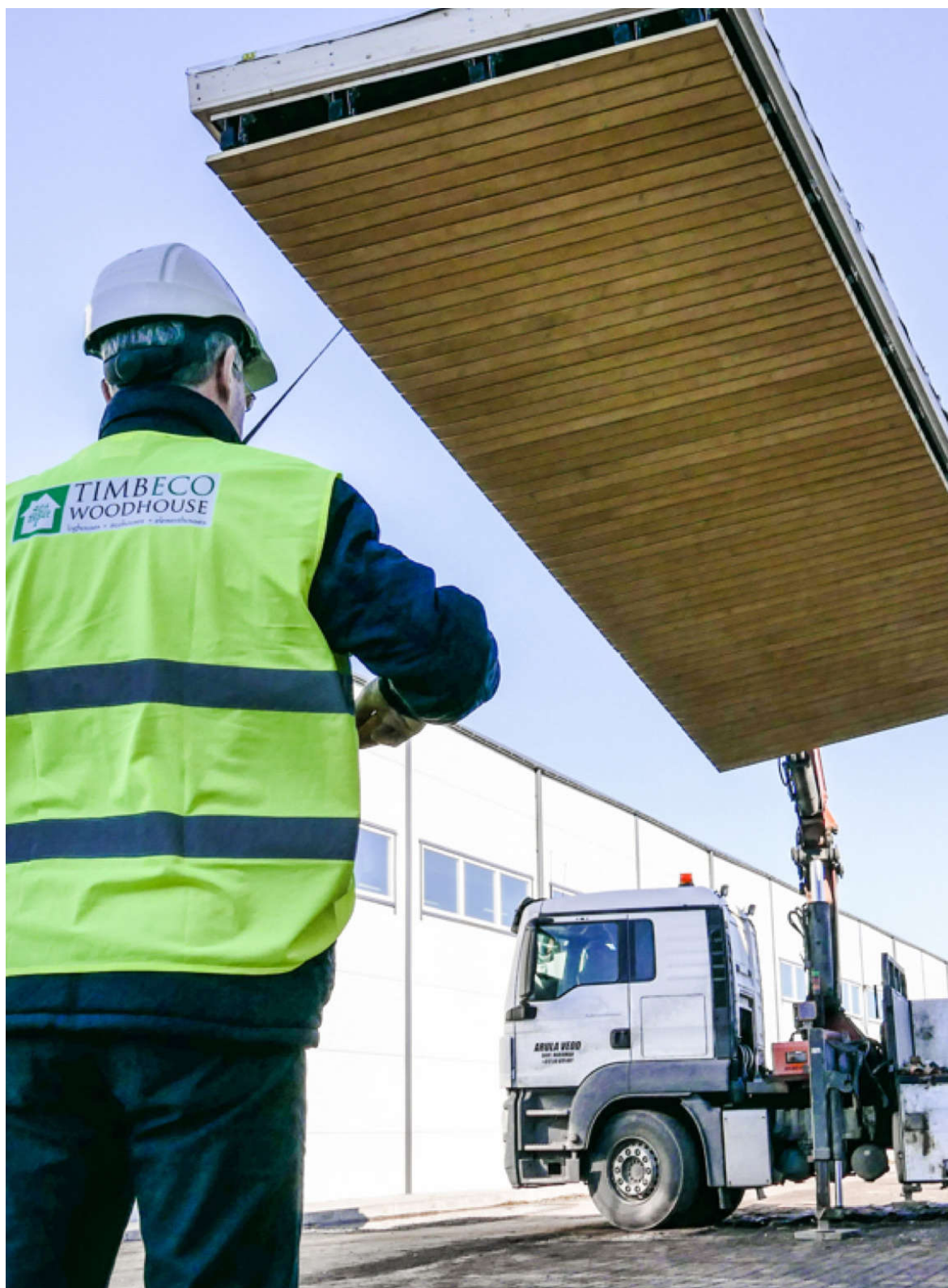
Joonis 3.17. Oodi objekti kumera-fassaadi riputatav välisseina element (T. Urva foto 2017).
