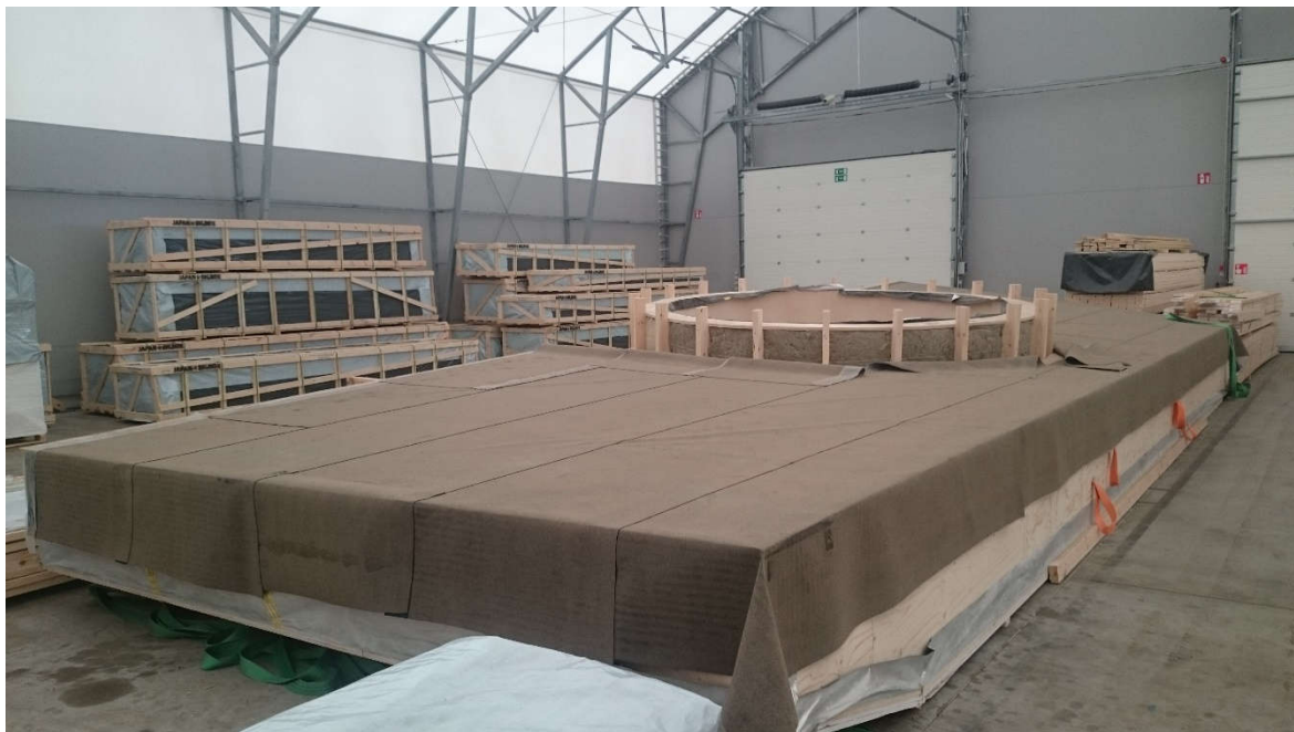
Joonia 3.16. Oodi näidis katuseelement valguskaevuga. Elemendi mõõdud: laius 4,26 m, kõrgus 1,31 m; pikkus 11,90 m ning valguskaevu sisemise ava läbimõõt 2,99 m. Selle katuseelemendi omakaal ligikaudu 8 tonni (T. Urva foto 2017).
