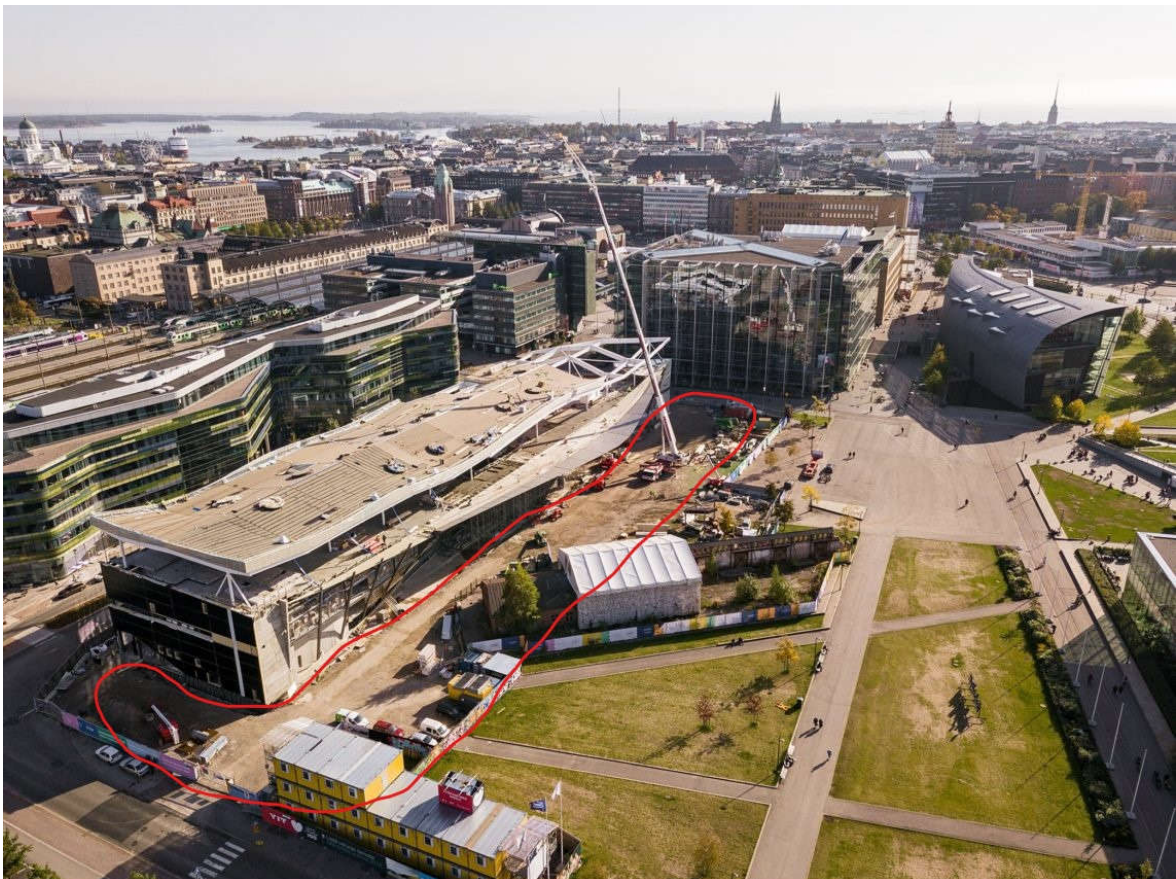
Joonis 3.21. Katuseelementide paigaldamiseks kasutatava kraana püstitamiseks piisav ala objektil tähistatud punase piirjoonega (T. Urva foto 2018).
