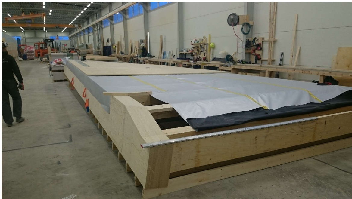
Joonis 3.18. Oodi objekti katuseelementide tootmine tootmishallis (T. Urva foto 2017).
