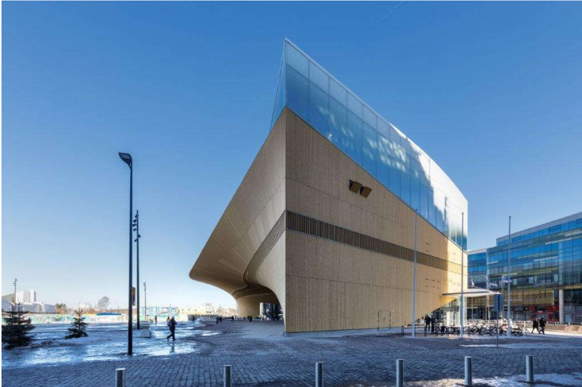
Joonis 2.3. Aasta tehasemaja 2019 konkursile esitatud Timbeco Woodhouse OÜ Helsingi raamatukogu fassaadi- ja katuseelementide projekt (S.Zjuganov foto 2019).
