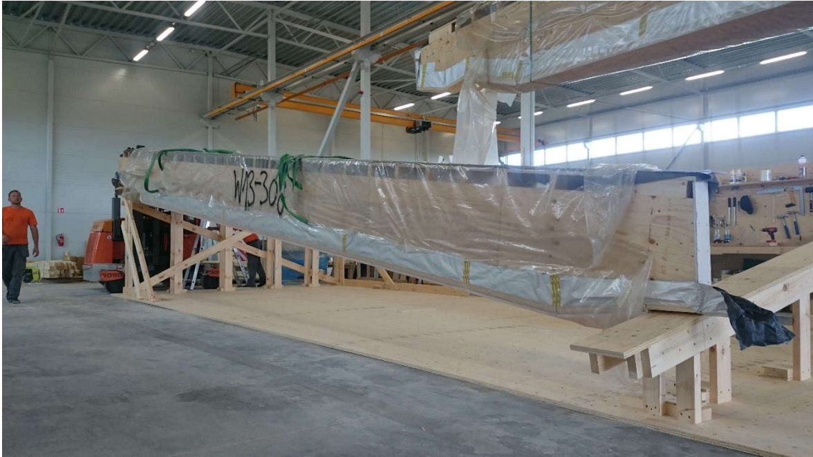
Joonis 3.23. Katuseelementide testpaigaldamine Timbeco tootmishallis (K. Koitla foto 2017).
