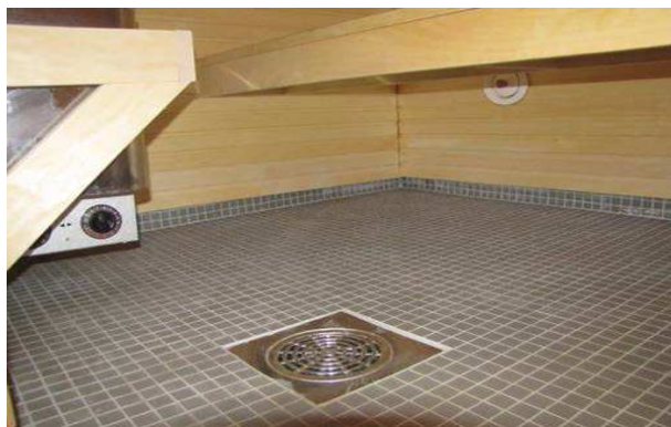
Joonis 2.3 Õhulekked põranda ja välisseina liitekohas; vasakul foto, paremal termopilt -50Pa juures (Kalamees jt, 2015).
