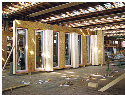
CLT 1 välisseinaelementide tootmine. Foto: M. Riistop
