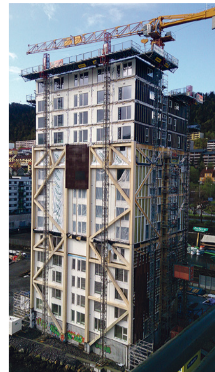
TREET ehitus. Korterite montaaž on lõppenud.
