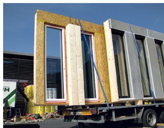
CLT 1 välisseinaelementide transport. Foto: M. Riistop
