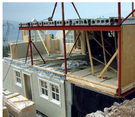
Kombineeritud kandekonstruktsiooniga tehasehoone. Foto: AS Matek
