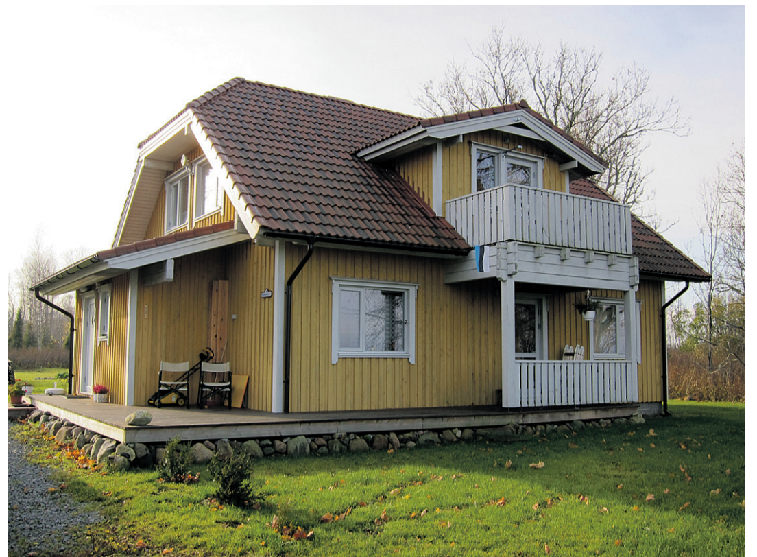
Jälgides säästvat energiakasutust ja loodussõbralikkust projekti ideest alates, on AS Ritsu toodetud Saaremaal asuv palkmaja täiendavalt soojustatud ka väljastpoolt. Seinte soojustamisel on hoidutud igasugustest hoonesse «kilekotiefekti» tekitavatest tuule ja niiskustökkematerjalidest. Foto: Ritsu AS
