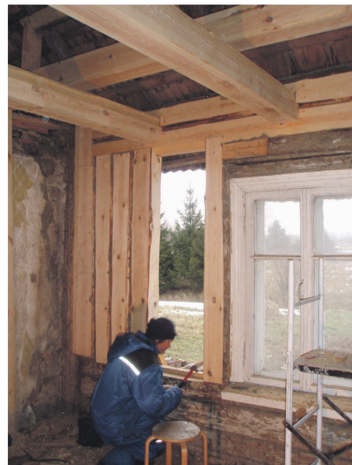
Suuremate kahjustuste korral võib palke asendada ka püstipidi, et vähendada hoone hilisemaid vajumisprobleeme.
