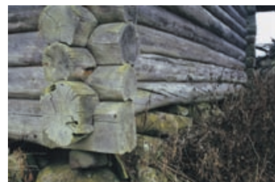
Suure keermega palgid (alumine palk) on soovitatav panna seinas hoone alumisse ossa, kuna sellised palgid on rahutumad.
