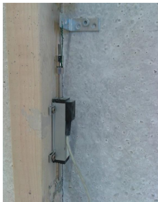
Joonis 3.19. Andur puidu ja betooni nihkumise mõõtmiseks
