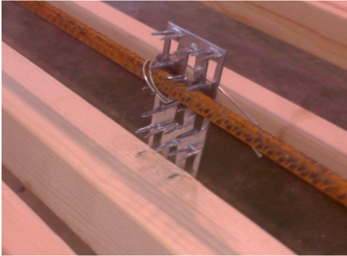
Joonis 3.6. MiTek TOP-W 36x62 mm ogaplaadi kinnitus armatuurvõrgu külge (foto: Priit Kirotar)
