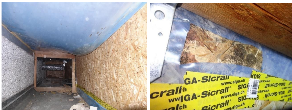
Joonis 46. Vee kogunemine aurutõkketihedele (vasakul) ja märgunud OSB-plaadi hallitamine (paremal).
