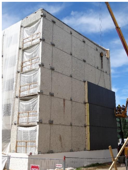
Joonis 26. Kinnituskronsteinide paiknemine fassaadil ning fassaadielementide paigaldamine alt ülesse.
