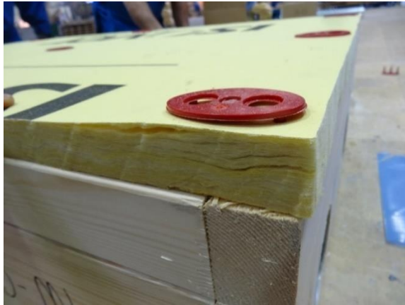
Joonis 21. Tuuletõkkevilla kinnitamine distantspuksidega (vasakul) ja tuuletõkkevilla vuukide teipimine ning tuulutusroovi paigaldamine (paremal).
