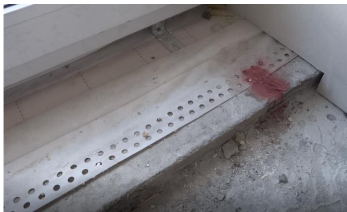
Joonis 30. Aknaavasse paigaldatud aurutõkketeip.
