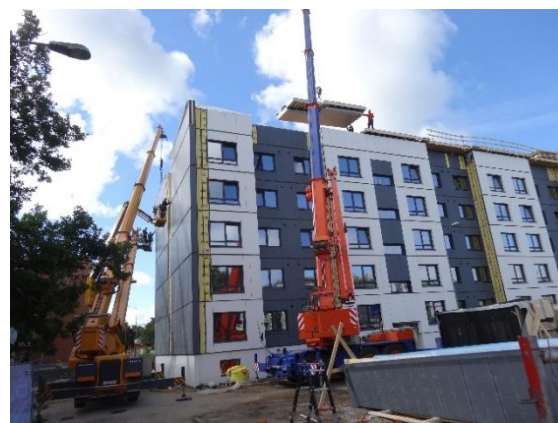
Joonis 40. Katuse lisasoojustuselemente kandev tolvärk (vasakul) (Sirkel ja Mall OÜ 2016). Katuseelementide paigaldamine (paremal).
