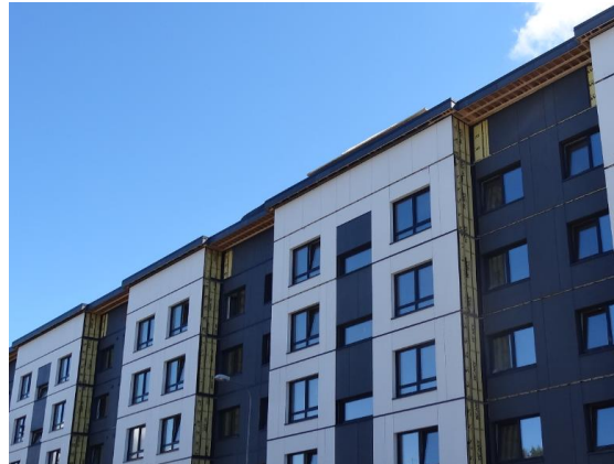
Joonis 41. Räästasarikate teipimine (vasakul) ja räästa katmine fassaadiplaadiga objektile (paremal).
