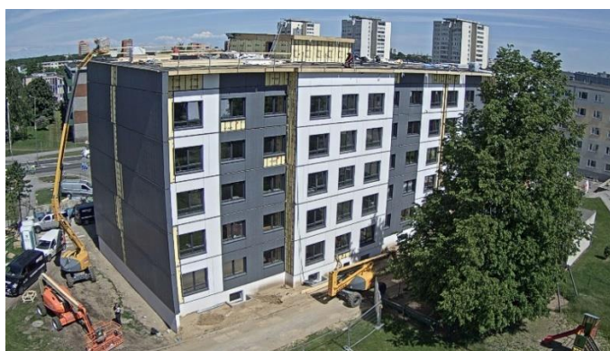
Joonis 16. Kohati paigaldati fassaadiplaadid objektil ( Time-lapse fotod).
