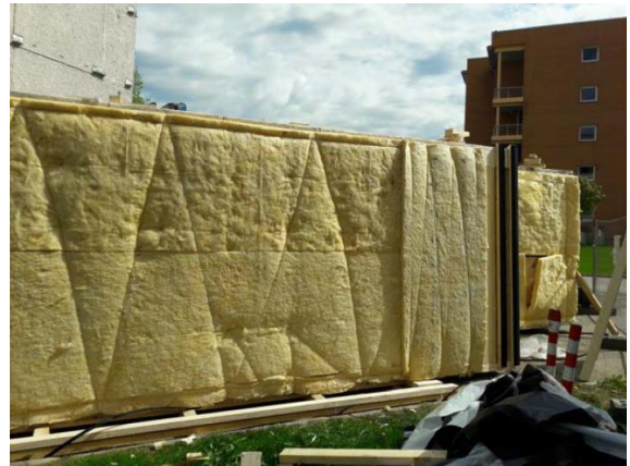
Joonis 22. Elemendi katmine fassaadikatteplaadiga (vasakul) ja puhvervilla kinnitamine nõöridega (paremal).
