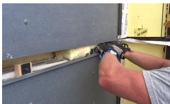
Joonis 33. Seinaelementide horisontaalvuukide täitmine montaaživahuga (vasakul) ja mineraalvillaga (paremal).
