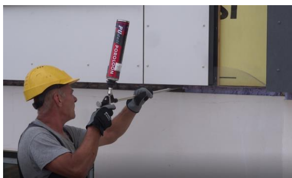
Joonis 33. Seinaelementide horisontaalvuukide täitmine montaaživahuga (vasakul) ja mineraalvillaga (paremal).
