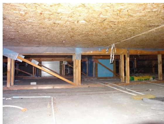
Joonis 39. Olemasoleva SBS-katte katmine mineraalvillaga (vasakul), katuse lisasoojustuselementide alune õhkruum (paremal).
