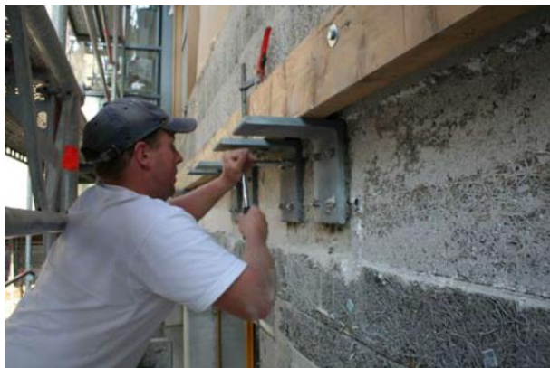
Joonis 5. TES Energy Facade seinaelementide toetamise viis (Lattke et al. 2011).
