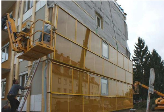
Joonis 6. ECBCS Annex 50 Austria projekti seinaelemendid (Zimmermann 2010).
