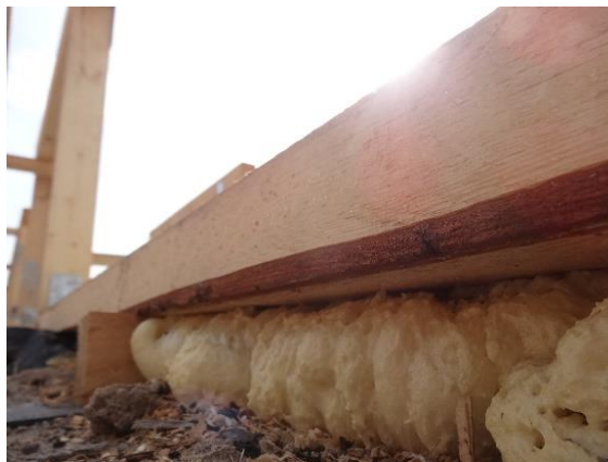
Joonis 44. Toolvärgi toetamine puidust klotsidele.
