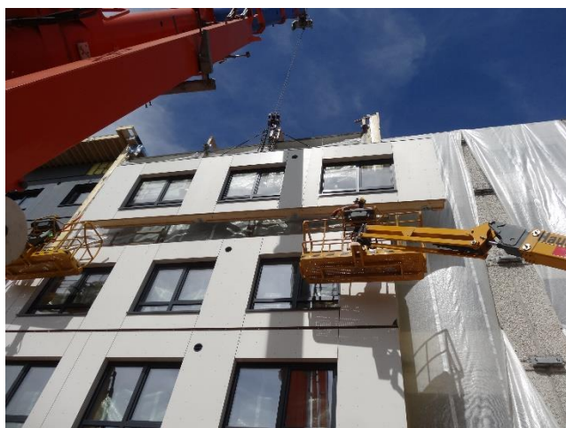
Joonis 27. Fassaadi lisasoojustuselemendi paigaldamine.
