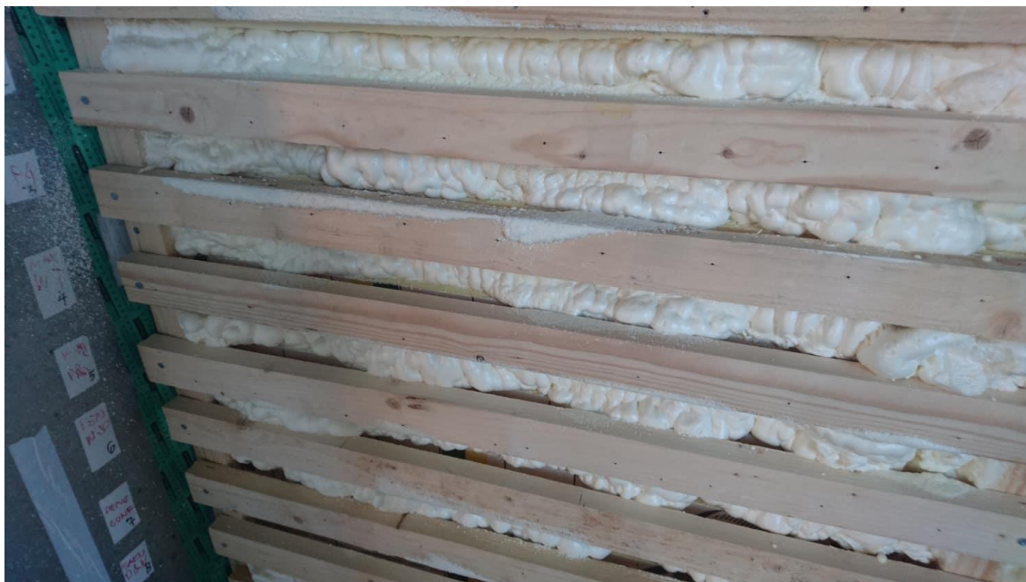
Joonis 52. PUR-vahuga seinaelementide horisontaalvuukide täitmine (autori foto).
