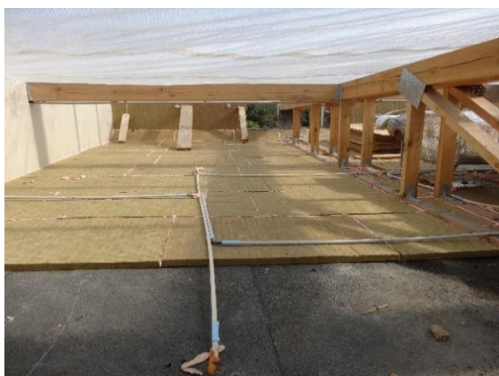
Joonis 39. Olemasoleva SBS-katte katmine mineraalvillaga (vasakul), katuse lisasoojustuselementide alune õhkruum (paremal).
