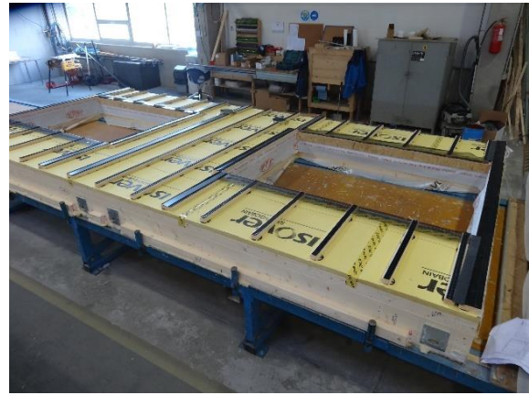
Joonis 21. Tuuletõkkevilla kinnitamine distantspuksidega (vasakul) ja tuuletõkkevilla vuukide teipimine ning tuulutusroovi paigaldamine (paremal).
