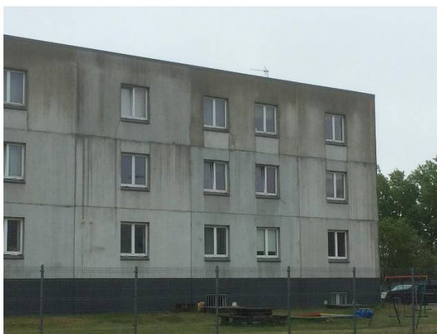
Joonis 4.6 Kaldvihma poolt põhjustatud fassaadi märgumine (Kalamees, erakogu)
