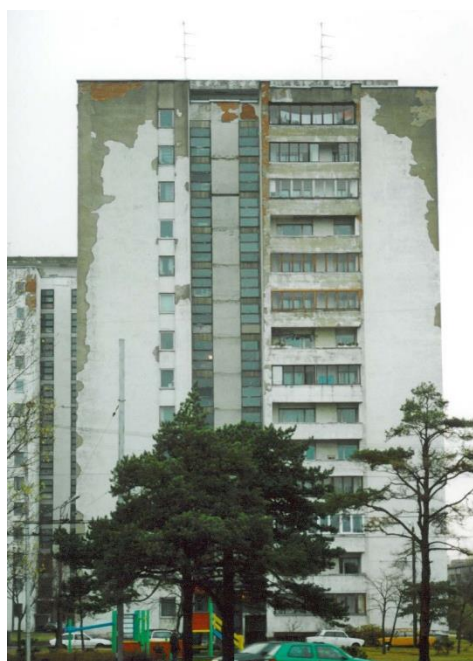
Joonis 4.6 Kaldvihma poolt põhjustatud fassaadi märgumine (Kalamees, erakogu)
