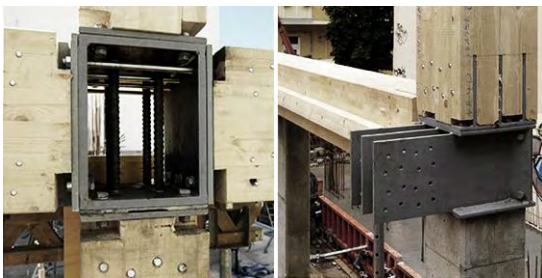
joonis 2. Näiteid massiivpuidu sõlmedest. allikas: J. Mayo „Solid Wood“
