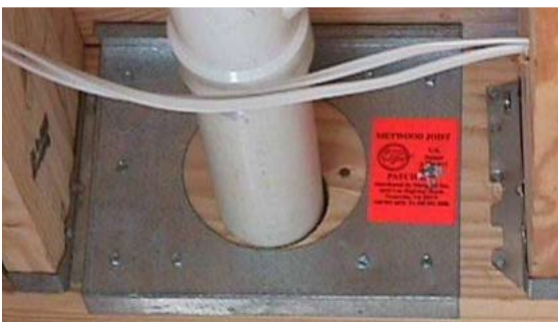
Joonis 1.22 Metwood 2810R lahendus torude jaoks [19].
