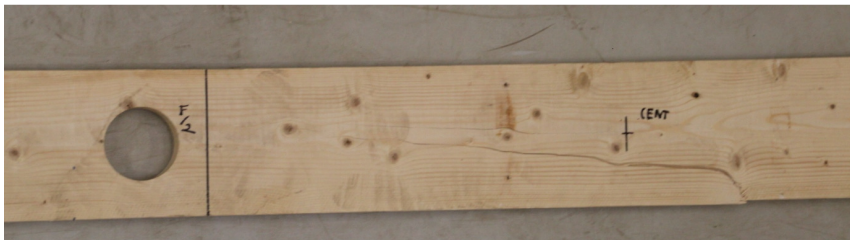
Joonis 3.12 Tala 12 purunemise koht.
